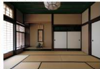
左 / 大広間 元々も広間であったが、勾配屋根部分を水平天井にするなど、柱梁の位置および向きが変更され、格の高い部屋となった。床の間と床脇は新設。 右 / 客室 ほとんどの部材が再利用された1階客室の座敷。床の間様の押入は、床脇風の意匠。 下 / ロビーからデッキ越しに、四季折々の変化を楽しむ庭と、その先の日本海が望める。
