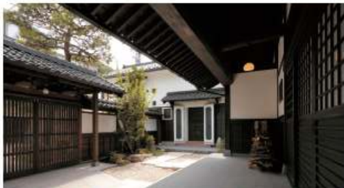
上/外観 東側道路から見る。古民家の移築再生だが、外観は大きく変わっている。 中/正面に障門を置き、その左右に障が漏なる。門かぶりの板は移植されたもの。 下/玄関ポーチ 軒に架かる長さ9mに及ぶケヤキの丸太梁は移植した土蔵からの転用。
