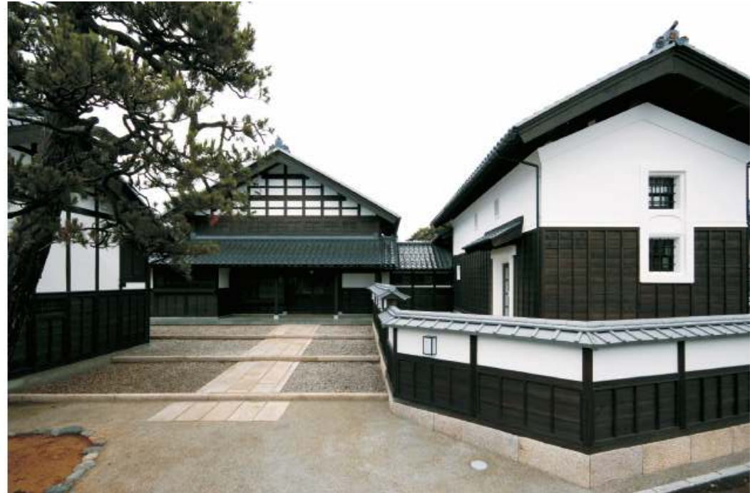
外観 この地方の伝統的な特徴は受け継ぎつつ、向き方により適した位置に移動して基礎工事を再生した。アプローチには御影石の延べ段が続く。大屋根の開口を広げ、ゆったりとした外観に。外壁は漆喰塗りとし、杉ささら下見張りの組み合わせ。
