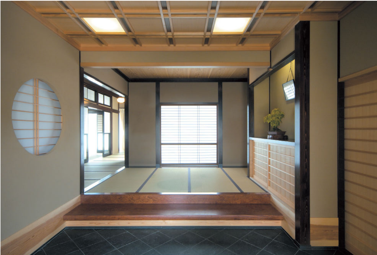
玄関 左手に丸窓を配した格天井の玄関。玄関床は玄關石、上り框は栗なぐり仕上げ、踏込みの床はケヤキ。玄関の左手はお父様、右手は若夫婦の空間。
